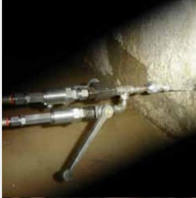
Cabeça de injeção bicomponente com misturador estático
